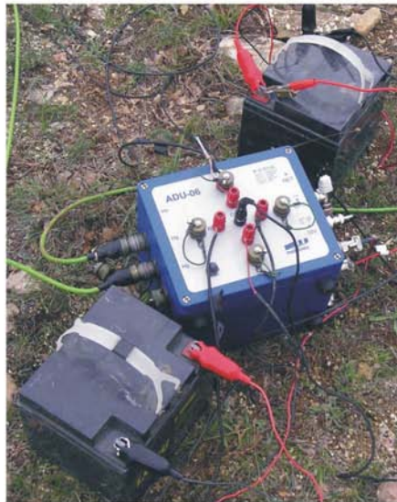
Unidad de registro y baterías
